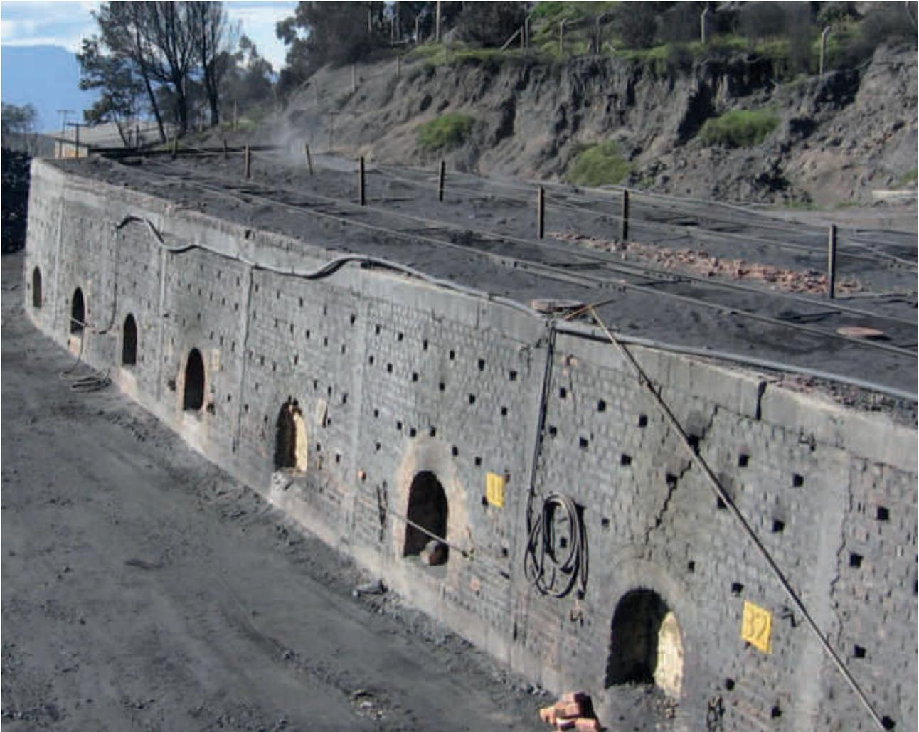
*Imagen #2, Baterías de coque, hornos tipo colmena*
