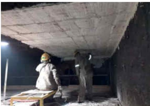
Hoy en día los equipos que se operan a elevadas temperaturas se encuentran en una búsqueda constante de poder aumentar la eficiencia del proceso y una de las alternativas es por medio de la disminución de las pérdidas de calor.
