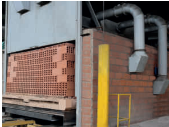
Salida horno túnel
